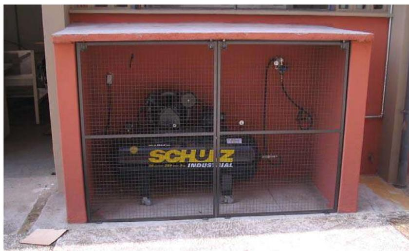
Figura 5.9 – Compressor do ensaio de névoa salina, IEE/USP (Foto: C. M. Ramos, 2005).
